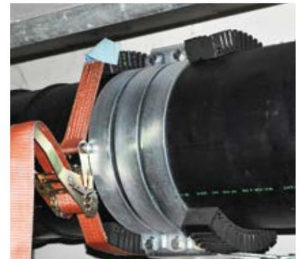
Anwendung als Festpunkt bei oberirdischer Rohrverlegung
