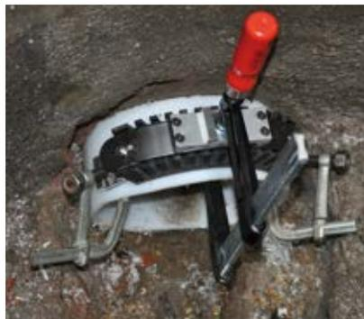
Anwendung Einzugsicherung bei einer Schachtanbindung
