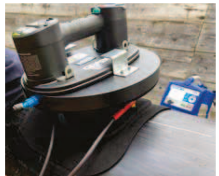
Während des Schweißvorgangs wird das Vakuum gehalten.
