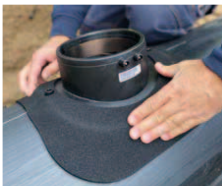
Mit der selbstklebenden Gummimatte wird bei ASA VL d160 der Sattel auf dem Rohr abgedichtet.
