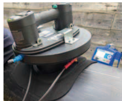
Während des Schweißvorgangs wird das Vakuum gehalten.
