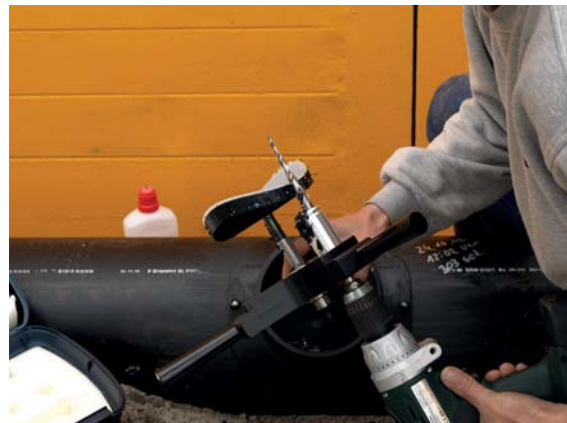
Abb. 3b: Rohrstück wird entnommen
