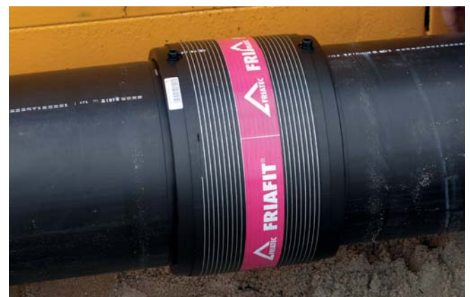
Abb. 2b: Fertige Rohrverbindung
