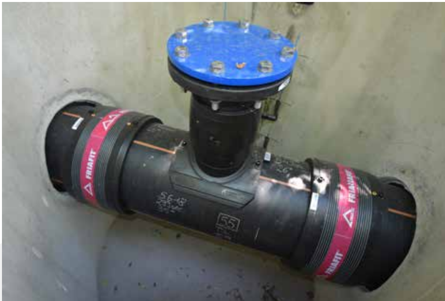
Für spätere Revisionsarbeiten werden in den Schächten Zugänge mit Flanschen vorgesehen
