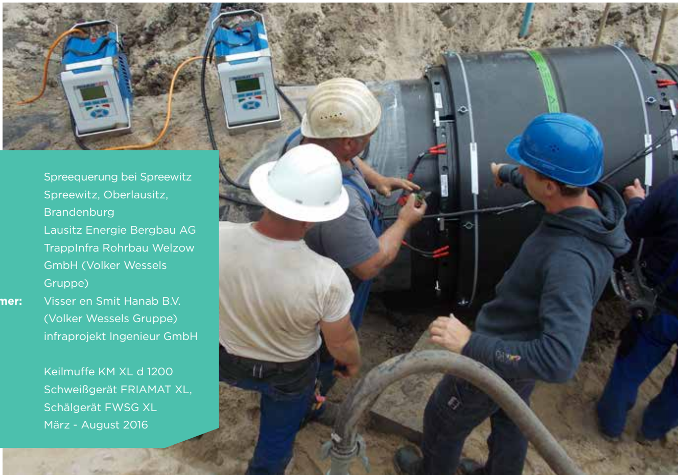
Die Schweißung kann durch den Einsatz von zwei Schweißgeräten, FRIAMAT XL, optimiert werden.
