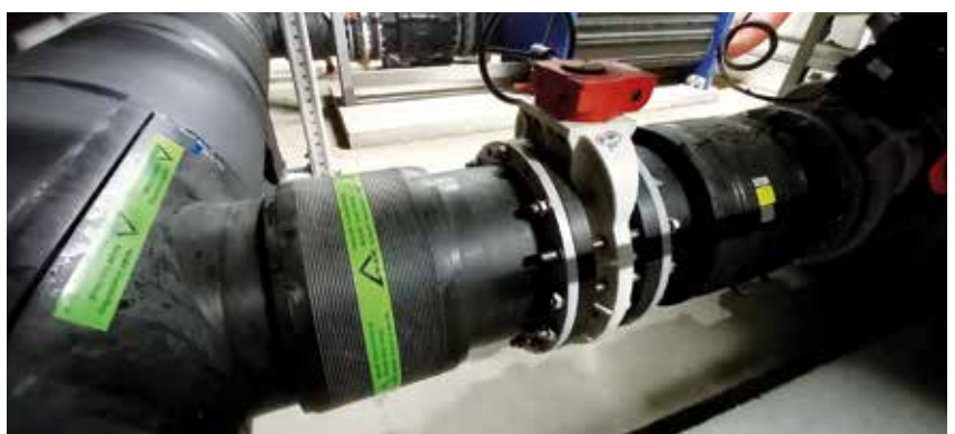
Abzweig mittels Sattel SA XL, Muffe UB, sowie Klappe FK
