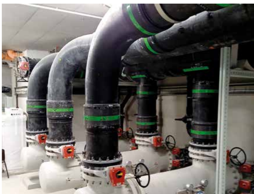
Die neuen PE-Leitungen in der Pumpstation
