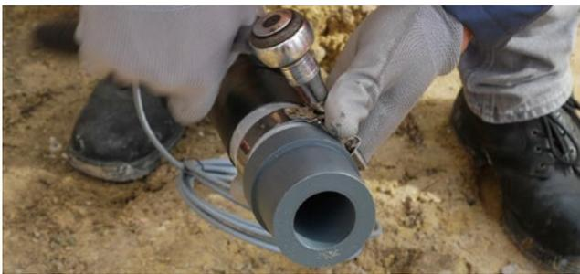
Die Edelstahlschellen werden verwendet, um das Innenrohr von ProtectaFlex Detect zu klemmen, um die Verbindung mit dem Standard-Fitting zu realisieren.
