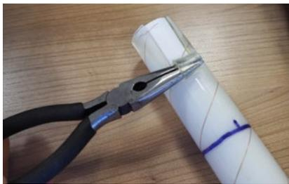
Greifen Sie das Ende mit einer Spitzzange und rollen Sie die PU-Hülle bis zur Markierung zurück.
