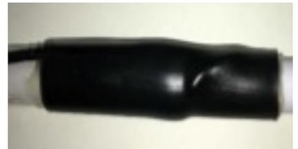
Erhitzen Sie den Schrumpfschlauch, bis dieser vollständig geschmolzen und glatt ist. Halten Sie die Wärmequelle in Bewegung, um ein Verkohlen zu vermeiden. Überprüfen Sie den sichtbaren Klebstoff an der Verbindungsstelle von Schlauch und Rohr. Dieser kleine Wulst aus herausstehendem Klebstoff bildet die Dichtung. Lassen Sie den gesamten Anschlussbereich abkühlen, bevor Sie ihn bearbeiten.
