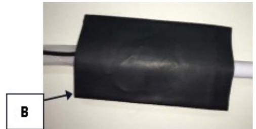
Stecken Sie das Rohr in den Schrumpfschlauch (B) und stellen Sie sicher, dass dieser das Ende des Widerstands und alle freiliegenden Drähte bedeckt.
