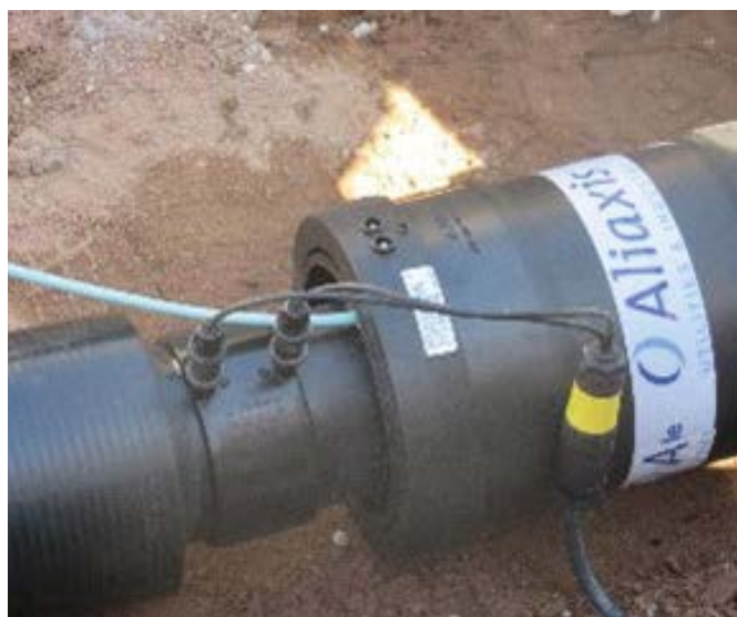
Bild 10: Verbindungstechnik Langmuffe
