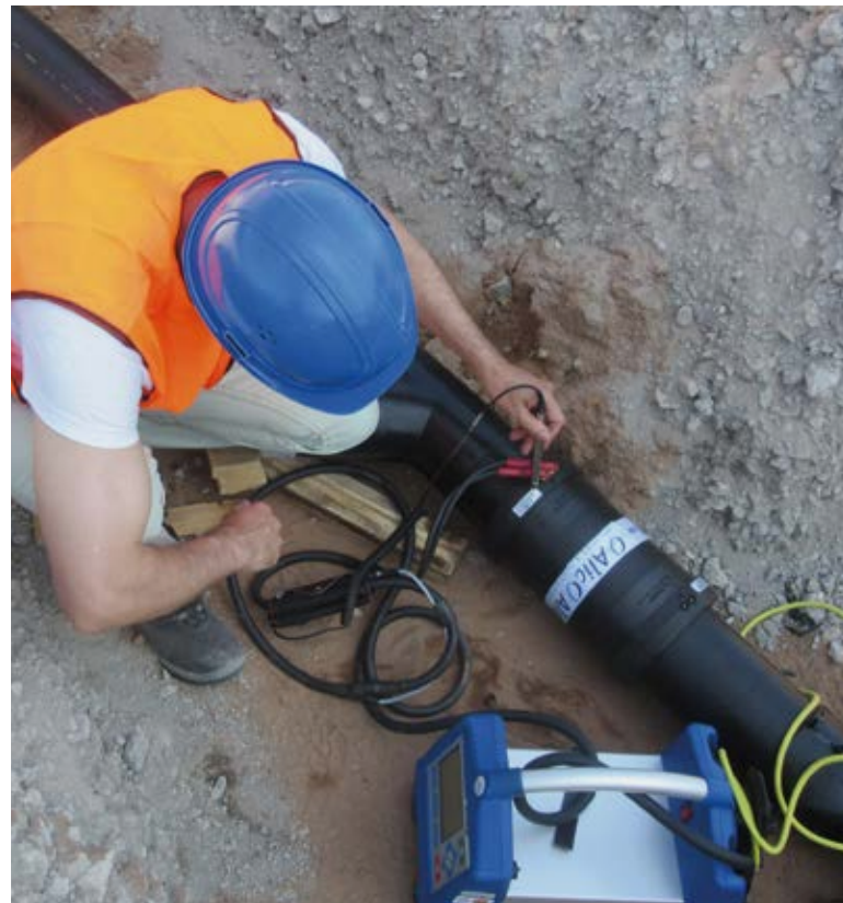
Bild 2: AkathermPlus Doppelrohrsystem Langmuffe
