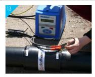
Nach erfolgreichem Schweißen und Abkühlen ist die Doppelrohrverbindung fertiggestellt und die Rohrleitung funktionsfähig.
