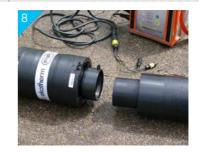
zweites Rohrende bis zum Mittenanschlag der inneren Heizwendelschweißmuffe einschieben
