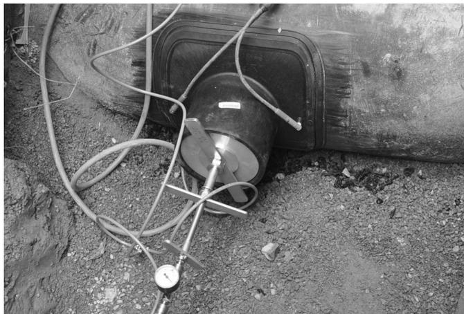
Vakuumspanntechnik mit VACUPUMP
