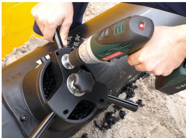
Montage mit Aufspann- und Anbohrgerät FWFIT
