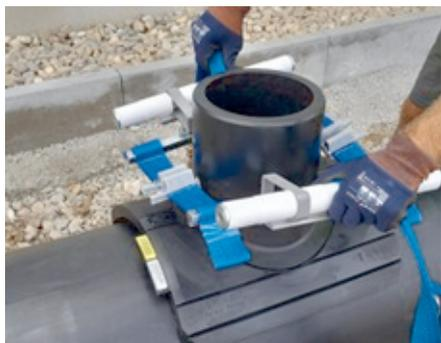
Platzieren Sie das Sattelbauteil SA UNI 225 / 250 auf die vorbereitete Rohroberfläche und führen anschließend die Spannmatte über den Abgang des Sattelbauteils SA UNI.
