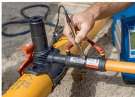
Führen Sie die Installation der Hausanschlussleitung durch. Beachten Sie dabei die allgemeinen Montageanforderungen für eine Heizwendelschweißung (Oxidschicht entfernen/reinigen). Siehe Kapitel 7. [Verarbeitung FRIALEN Sicherheitsfittings](#), S.18 und 8. [Montage und Verarbeitung: Muffen und Formteile](#), S.25
