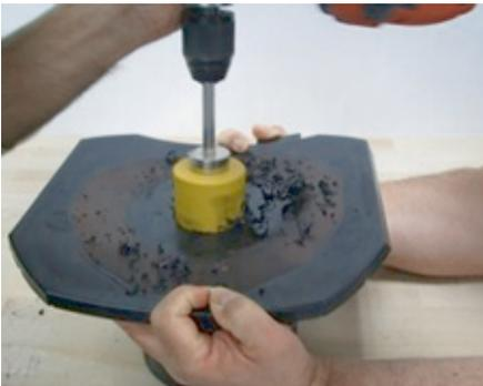
Beim Anbohren unter Betriebsdruck muss vor der Montage des SA UNI auf die Rohrleitung der Prüfanschluss am SA UNI entfernt werden. Bohren Sie den Prüfanschluss mit einem Bohrer (Lochsäge d 50mm bis d 65mm) heraus.
