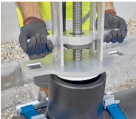
Demontieren Sie anschließend die Spanneinheit vom Abgang des Sattelbauteils SA UNI 225 / 250. Ziehen Sie dafür die Spanneinheit aus dem Abgang der SA UNI 225 / 250 heraus und legen Sie die Spanneinheit zurück in den Transportkoffer.
