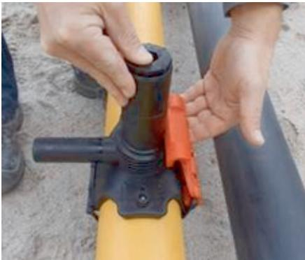
Positionieren Sie die Druckerbohrarmatur DAA RED SNAP auf die gewünschte Endposition auf dem Rohr. Spannen Sie anschließend durch Betätigen des Schnellspannhebels nach oben, die Druckerbohrarmatur DAA RED SNAP fest auf das Rohr.
