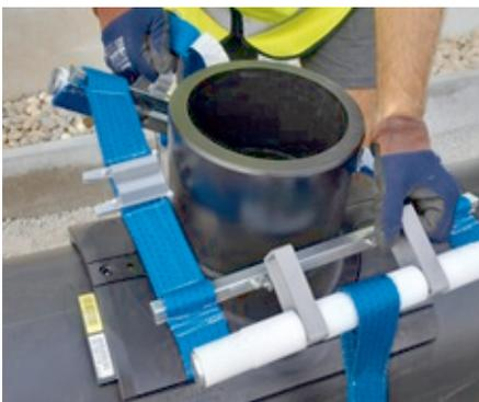
Durch Lösen des Untergurts am Rohr, indem die Gurtratsche geöffnet wird, kann die Spanmatte über den Abgang des Sattelbauteils SA UNI 225 / 250 abgezogen werden. Verstauen Sie anschließend auch die Spanmatte im Transportkoffer.
