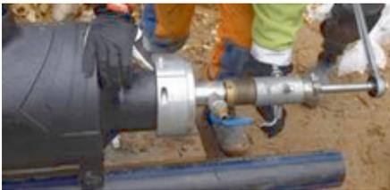
Für die Anbohrung von Rohrleitungen unter Betriebsdruck wird ein externes Anbohrgerät (z.B. von Hütz und Baumgarten) benötigt, welches die Anbohrung durch ein Absperrorgan (z.B. FRIALOC) ermöglicht.
