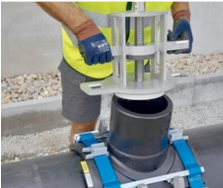
Montieren Sie auf den Abgang des SA UNI die Spanneinheit.
