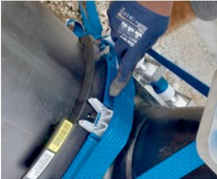
Achten Sie bei der Spanngurtmontage darauf, dass die Gurtnaht über dem Scheitelanschlag positioniert ist. Dadurch wird eine gleichmäßige Aufspannung gewährleistet.
