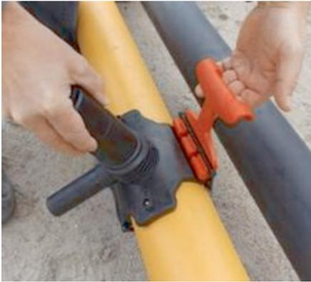
Die Druckerbohrarmatur DAA RED SNAP ist nun auf dem Rohr vorgespannt, kann aber noch bewegt werden.
