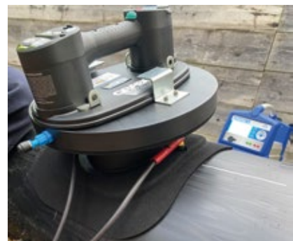
Während des Schweißvorgangs wird das Vakuum gehalten.
