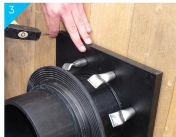
Eine Befestigung der Wanddurchführung an den metallischen Hülsendübeln ist nicht zulässig. Direkter Kontakt mit den Armierungseisen oder dem Befestigungsdraht kann langfristig zu Beschädigungen an den Hülsendübeln (Korrosion) führen.
