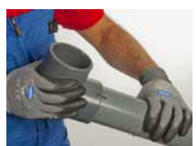
Verklebte Teile unverzüglich und gleichmäßig verbinden. Überschüssigen Klebstoff entfernen
