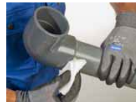
Verklebte Teile unverzüglich und gleichmäßig verbinden. Überschüssigen Klebstoff entfernen
