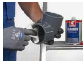
Rohrober- und Muffeninnenfläche reinigen
