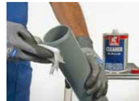
Rohrober- und Muffeninnenfläche reinigen
