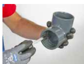
Kleber am Rohr und Fitting gleichmäßig auftragen
