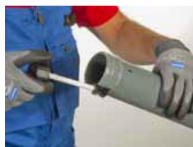
Kleber am Rohr und Fitting gleichmäßig auftragen
