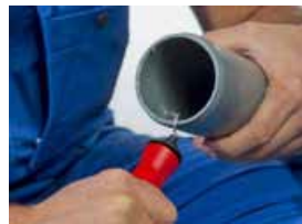
Rohr auf Länge schneiden und Rohrende anfasen
