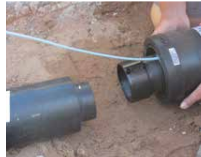
Medienrohr verbinden
