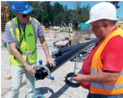
Schutzrohr schälen
