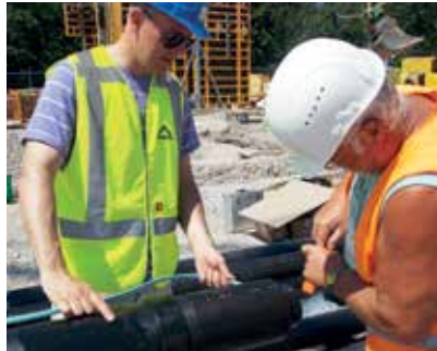
Medienrohr bearbeiten
