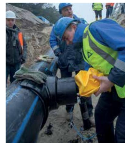
Bild 2: Einbringen des Reparaturballons
