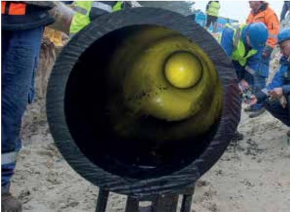
Bild 3: Der Reparaturballon dichtet im Rohr gegen nachfließendes Wasser ab.
