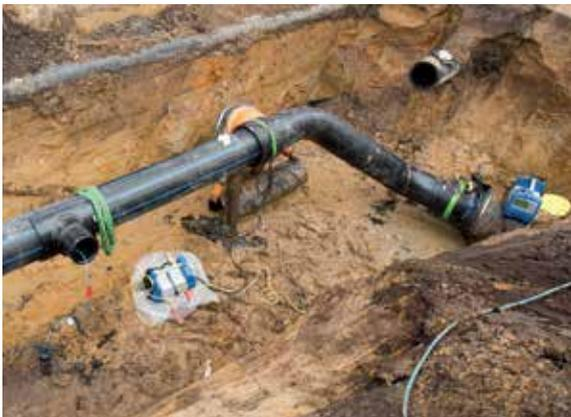
Bild 5: Einbau Etage-Bogen d 355 / 45°
