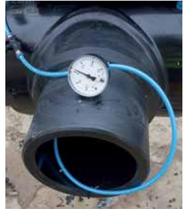
Bild 4: Überwachung der Absperrung mittels Manometer
