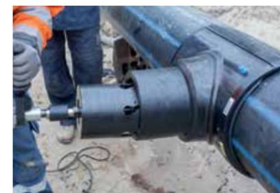
Bild 1: Anbohren der Leitung durch die Stutzenschelle SA XL d 355 / d 225
