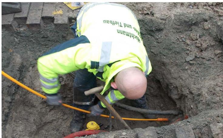
Der Anschluss an das schnelle Internet erfordert damit nur einen Bruchteil der Kosten gegenüber der herkömmlichen Verlegung der Glasfaser im offenen Graben. FRIATEC hat mit FRIANET die Technologie für die absolut gas- und druckdichte Einbindung des Leerrohrs für den Betrieb der Gasleitung entwickelt. Als Leerrohr wird ein PE-Gasrohr PE 100, d 16 x 3,0mm verwendet. Die Einbindung erfolgt nach dem Standard-Heizwendelschweißverfahren, homogen, sicher und dauerhaft gasdicht.
