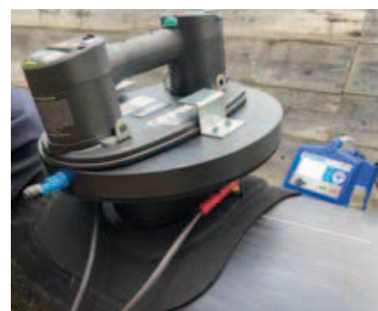
Während des Schweißvorgangs wird das Vakuum gehalten.
