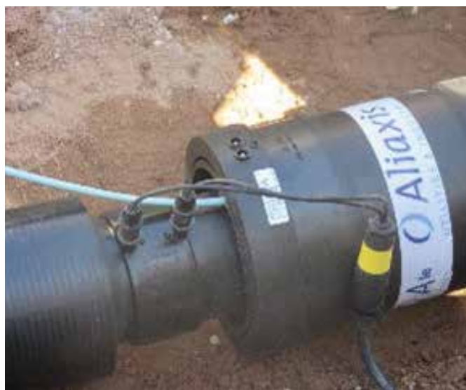
Bild 10: Verbindungstechnik Langmuffe
